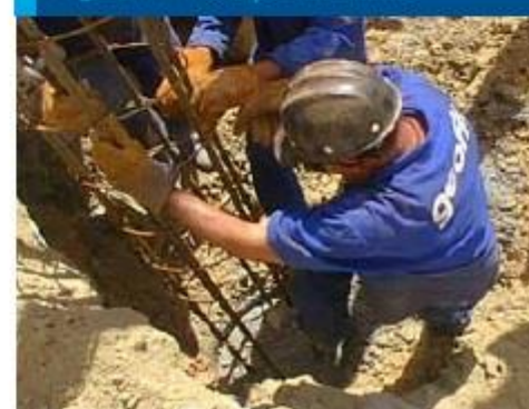
Figura 8 • Instalação da armadura
