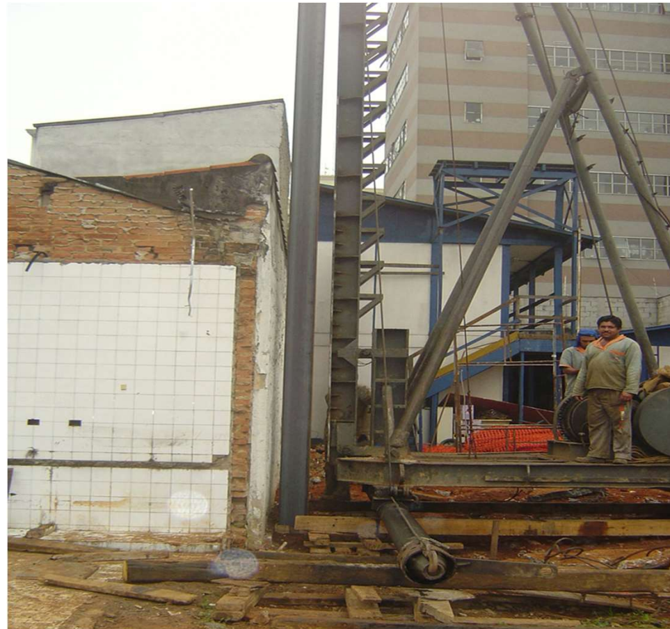
Perfil metálico de contenção junto à divisa
