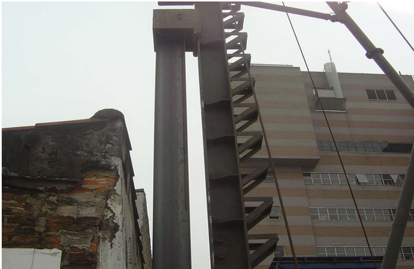
Perfil metálico de contenção junto à divisa
