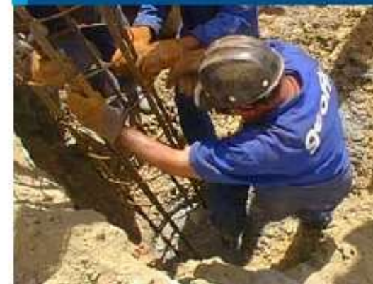
Figura 8 - Instalação da armadura
