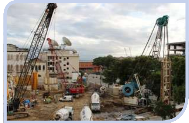
Racional Engenharia - Novas Instalações Loreal - Rio de Janeiro/RJ
