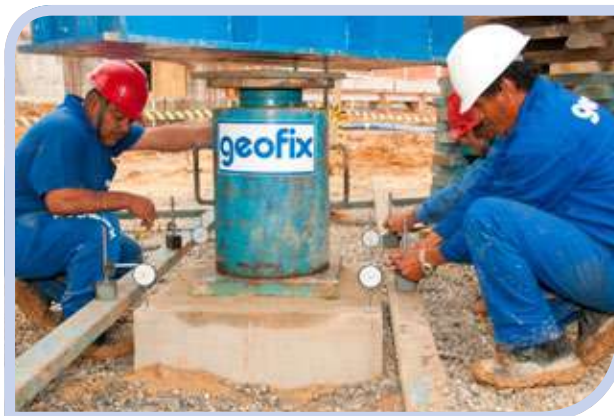
Even Construtora e Incorporadora - Ed. Giardino - São Paulo/SP
